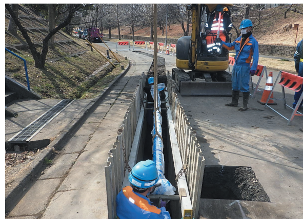
取替工事の様子
