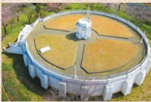
千葉分場1号配水池
