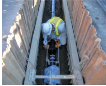
配水管の取替工事
