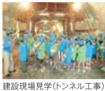
建設現場見学(トンネル工事)
