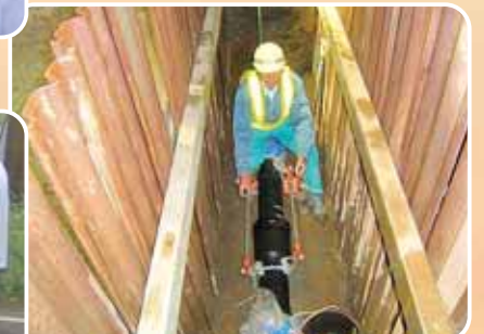
災害時にも有効な耐震継手への取り替え工事
