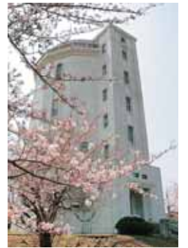
千葉高架水槽
