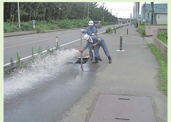
水道管の洗浄作業
