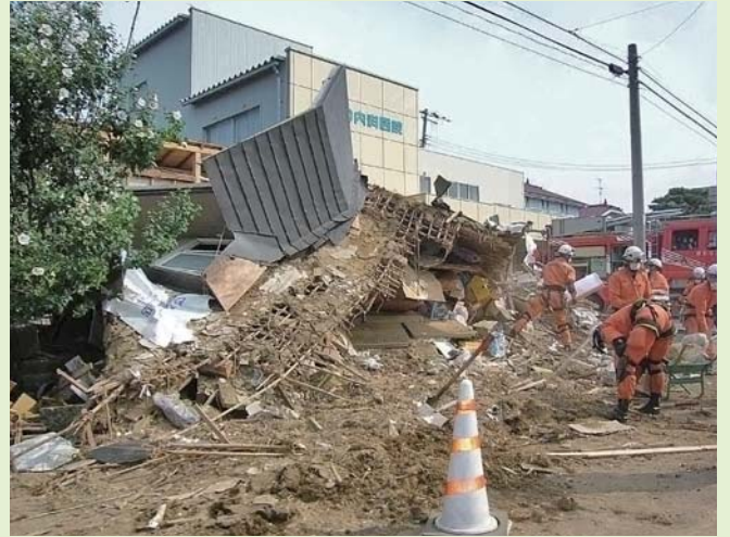
倒壊した家屋
