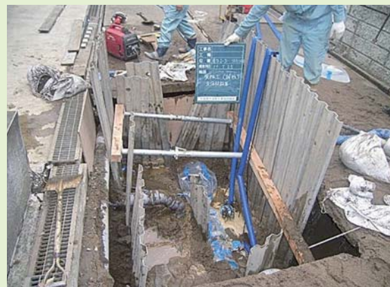
水道管の復旧
