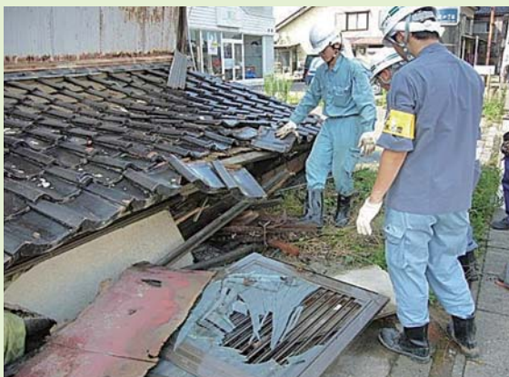
宅地内の漏水調査
