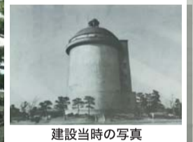
建設当時の写真
