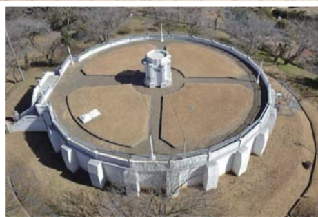
千葉分場1号配水池
