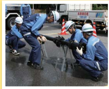
漏水修繕の応急復旧訓練
