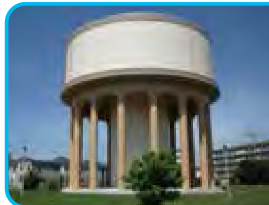
船橋高架水槽
