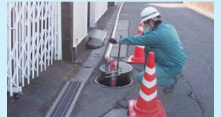
配水管の定期洗浄
