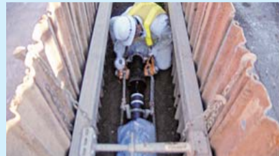
配水管の取り替え工事
