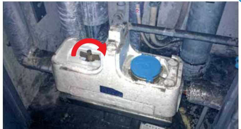
量水器室内(一般的なマンション等)※発泡スチロールに覆われたメーター
