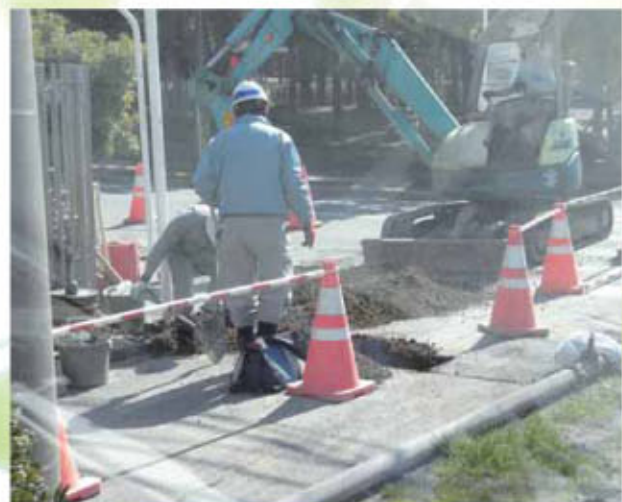
▲漏水個所の工事風景
