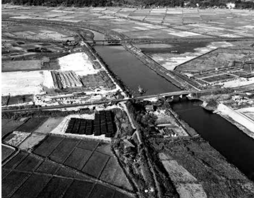
(昭和 40 年 建設中の佐倉浄水場)
