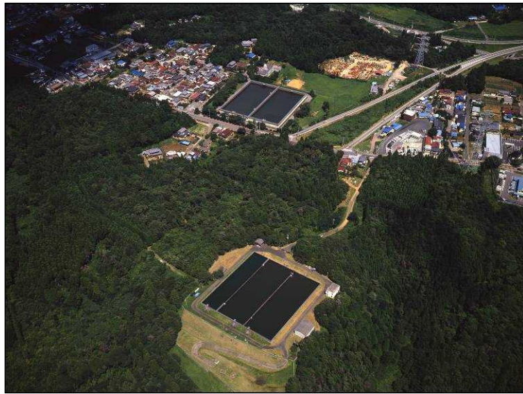
図-2.13 鎌取配水池(上側)及び清水台配水池(下側)
