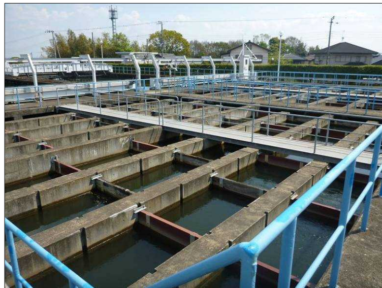
図-2.10 郡本浄水場(3・4号沈殿池)
