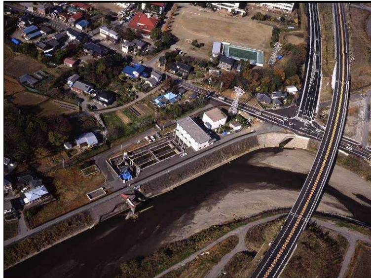
図-2.17 湊川取水場
