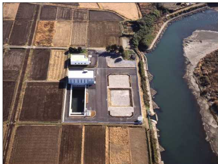
図-2.8 西広取水場
