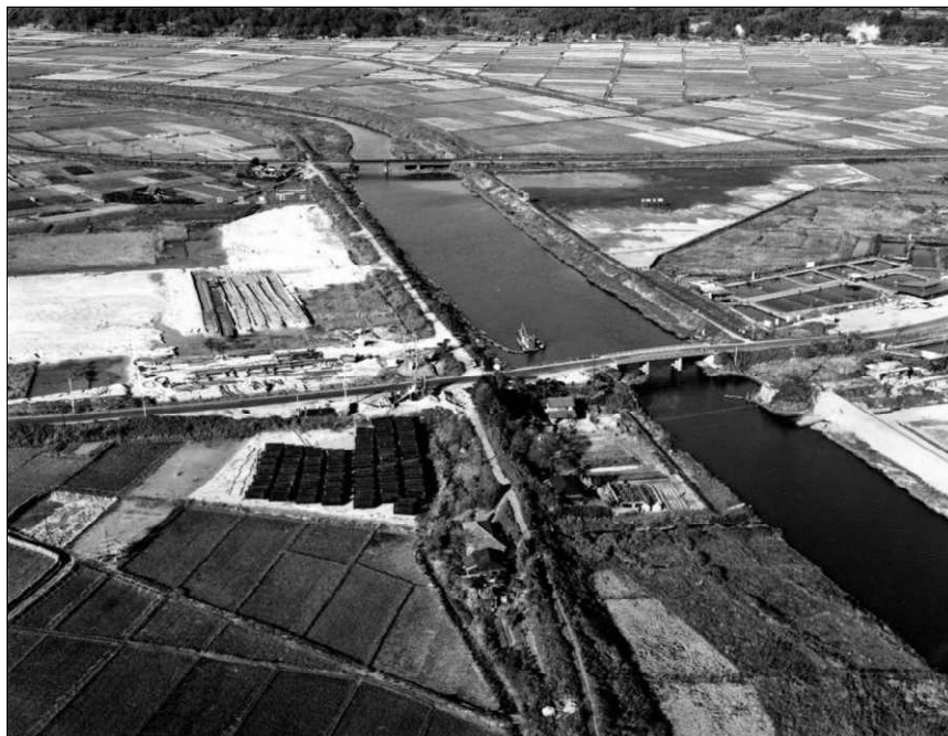
(昭和 40 年 建設中の佐倉浄水場)
