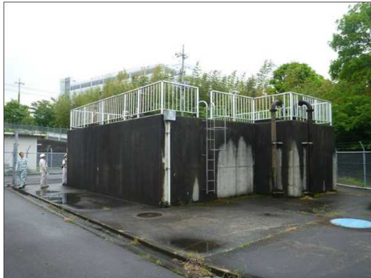
図-2.19 空港南部給水場
