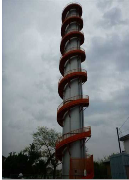
図-2.6 間野台調圧塔
