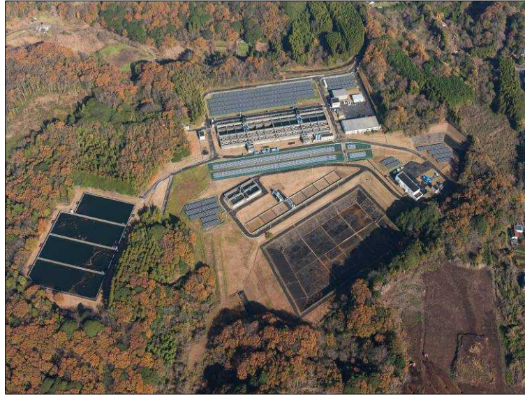
図-2.15 袖ヶ浦浄水場
