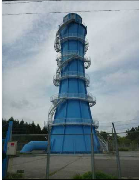
図-2.12 羽鳥調圧塔
