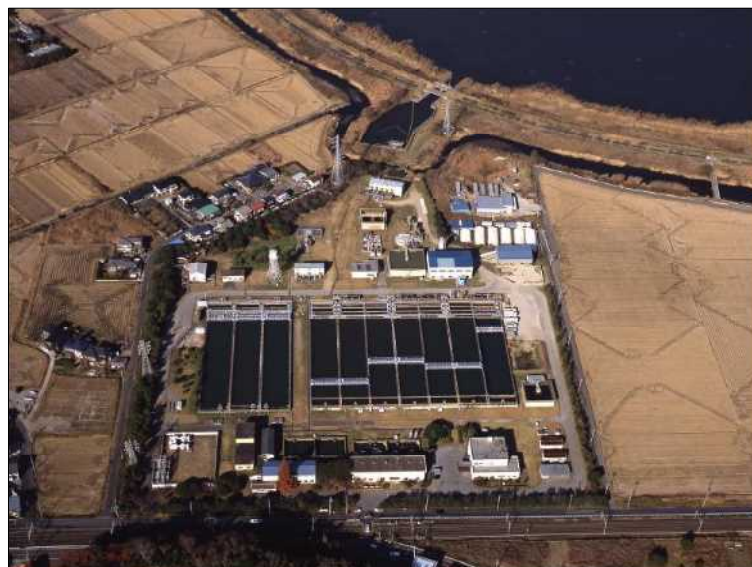
図-2.5 印旛沼浄水場
