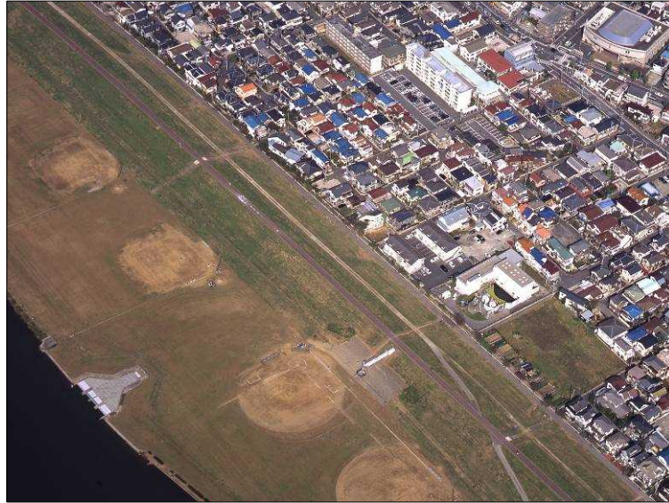
図-2.3 大和田取水場
