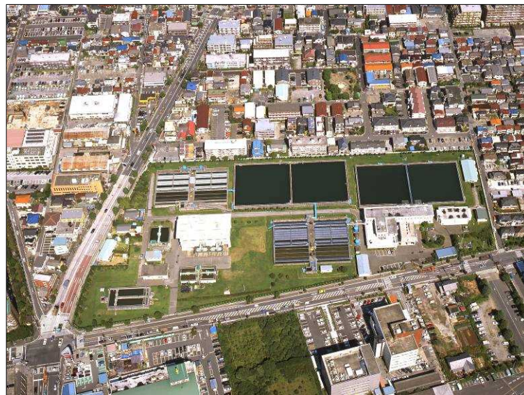
図-2.4 南八幡浄水場
