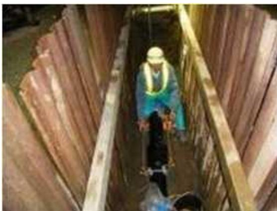
図1-4 水道管交換の様子
