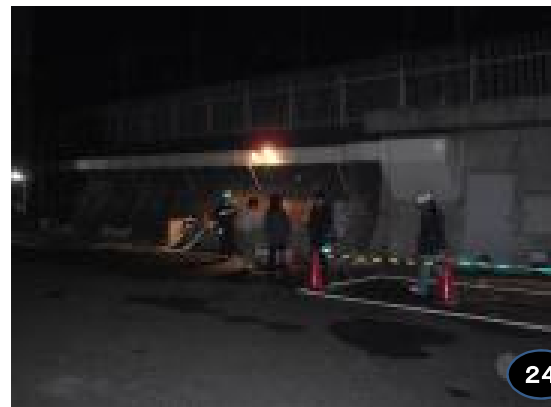
妙典給水場での給水への
