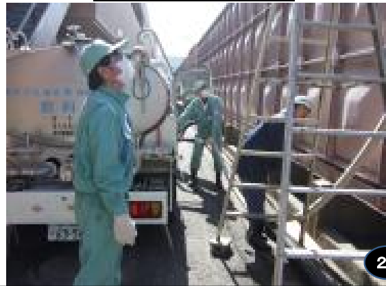
給水車から受水槽へ注水
