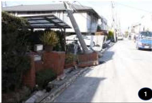
電柱倒壊
