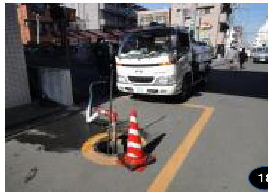
消火栓から給水車へ充水
