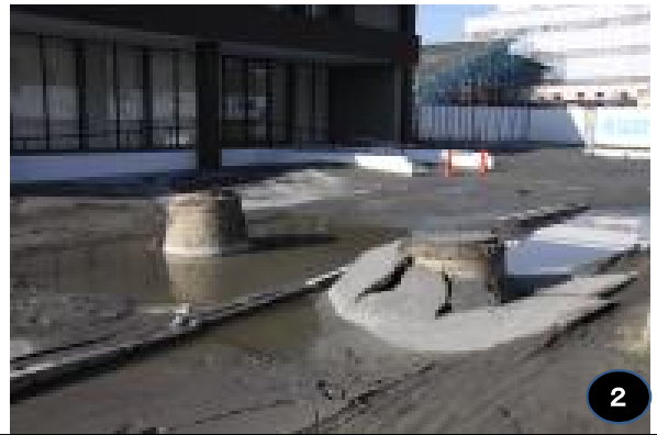
下水道マンホール
