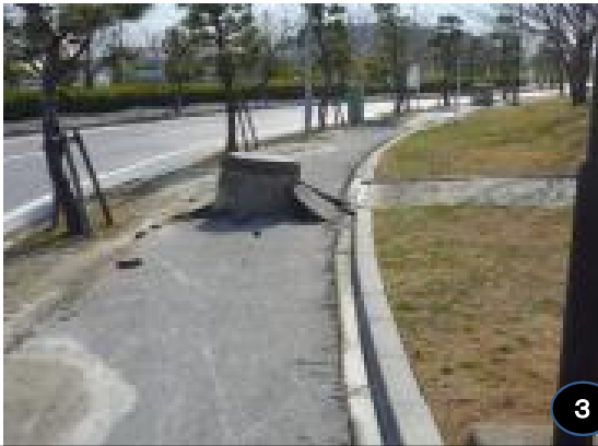
下水道マンホール
