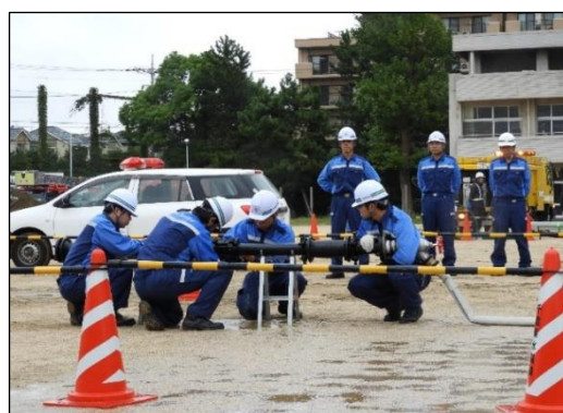
応急復旧作業（ライフライン復旧訓練）
