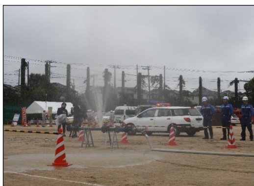
水道管の漏水再現（ライフライン復旧訓練）
