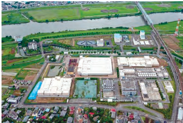
図V—3 ちば野菊の里浄水場（第2期）施設整備事業
