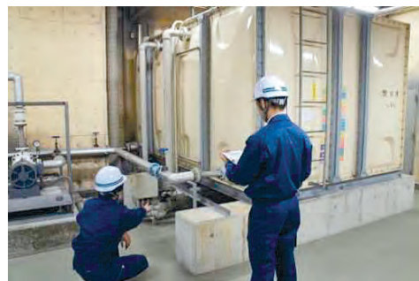
図V—8 貯水槽の点検の様子
