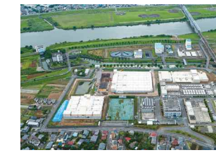
ちば野菊の里浄水場
