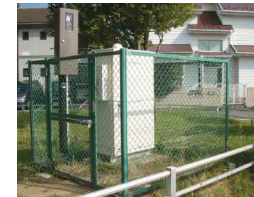
水質自動監視装置
