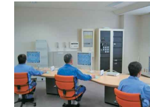
浄水水質管理(中央管理室)
