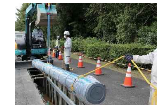
配水管の布設替え
