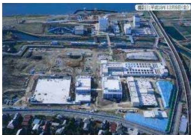
建設中の「ちば野菊の里浄水場」
