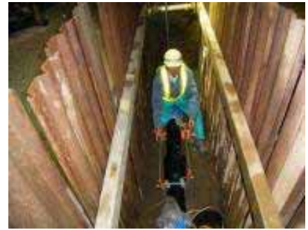
配水管の布設替え工事
