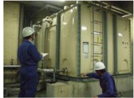
▲貯水槽巡回サービス
