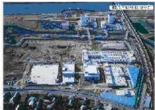
▲建設中の「ちば野菊の里浄水場」
