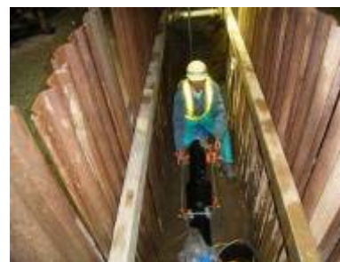
▲配水管の布設替え工事
