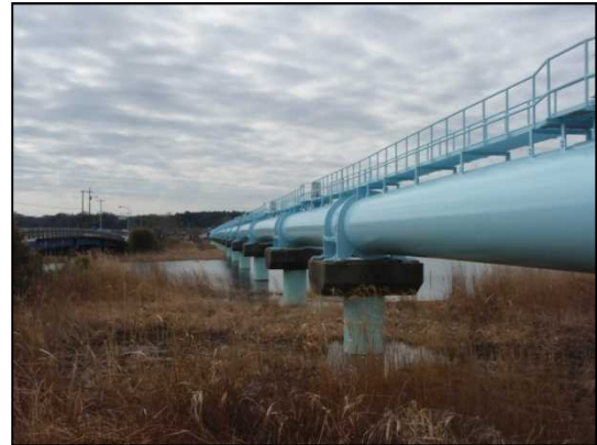
図 15 水管橋塗装（船戸）
