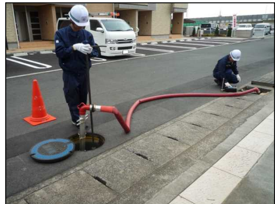
図 17 管内洗浄の様子
