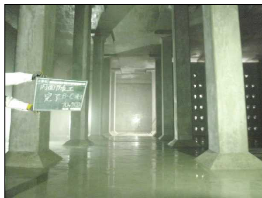
図11 配水池の防水塗装
