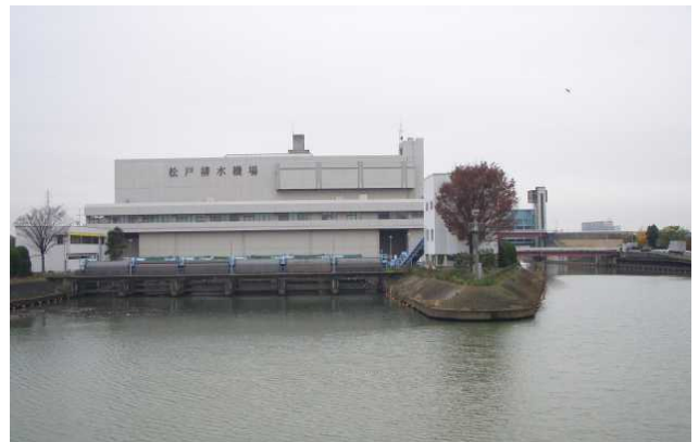
松戸排水機場 (坂川)
