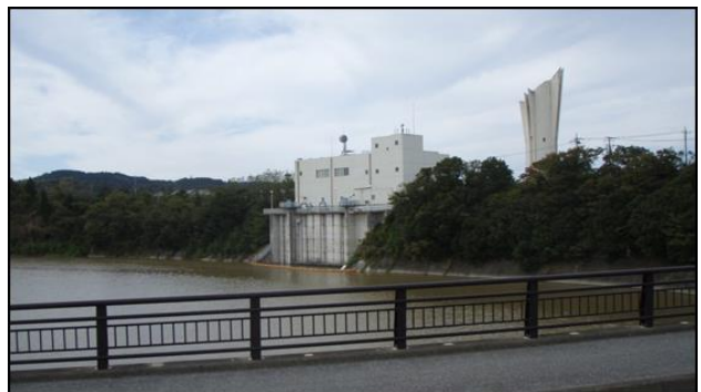
高滝取水場 (高滝ダム)
