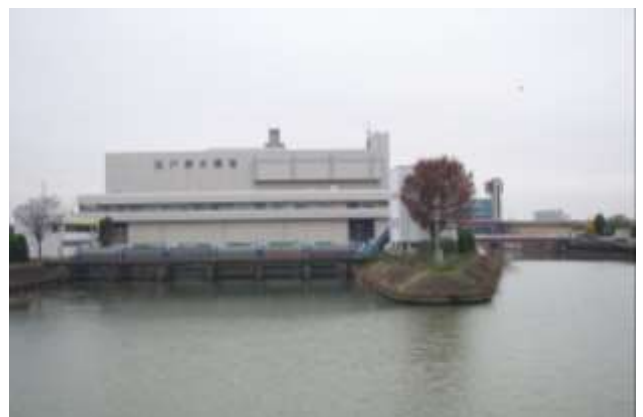
松戸排水機場 (坂川)
