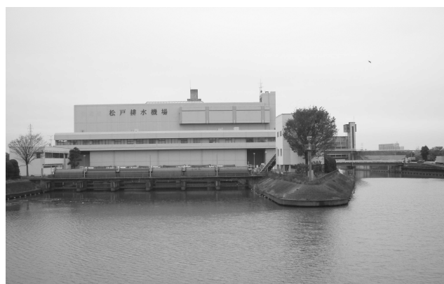
松戸排水機場 (坂川)
