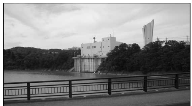
高滝取水場 (高滝ダム湖)
