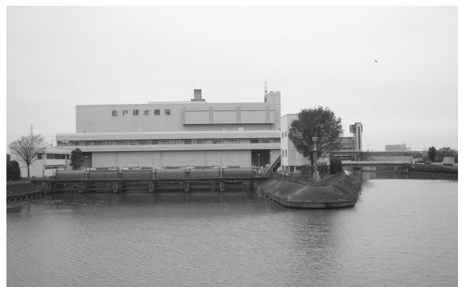
松戸排水機場 (坂川)
