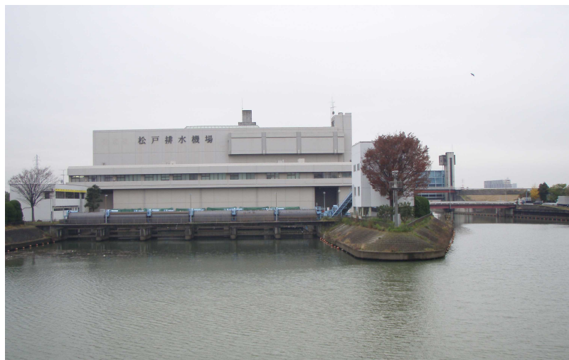
松戸排水機場（坂川）
