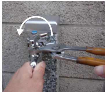
② 蛇口を手でしっかりとささえ、スパナ等で上部を左↶に回してゆるめ、ハンドルを全開にします。
