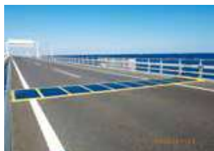
養生後 (ゴムマット設置)
