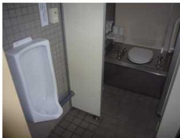
・一基を洋式トイレに交換 ・手すりを設置
