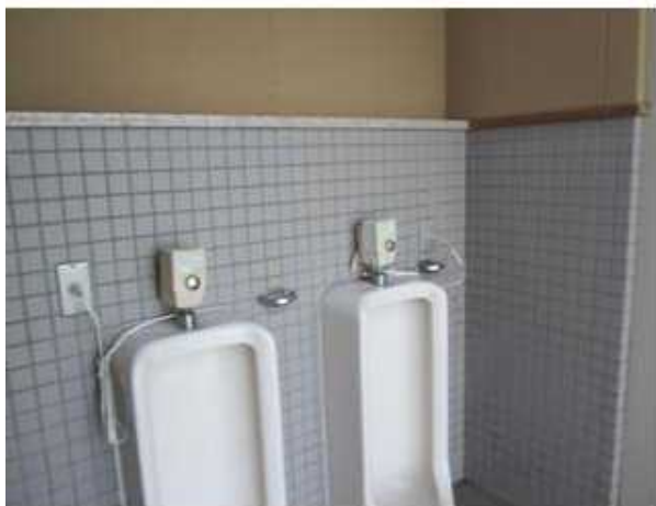
・男子トイレ (小便器二基)
