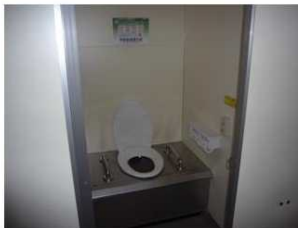
・洋式トイレに交換 (二基) ・手すりを設置
