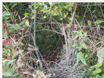
動物による破損
