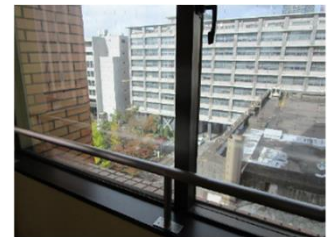
断熱性の低い単層ガラスの窓
