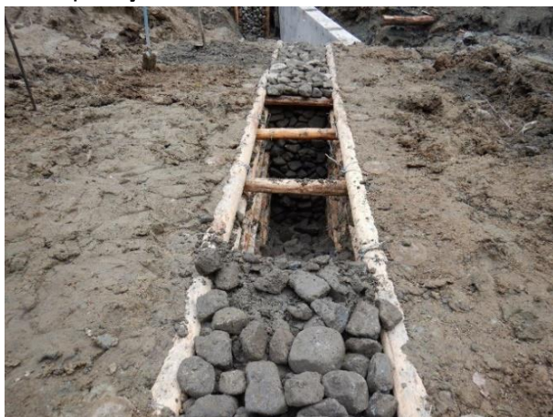
暗渠工（県産材）
