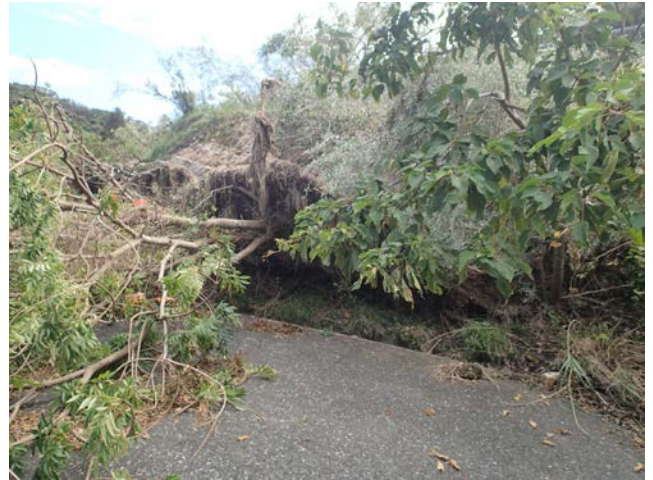
(↑道路沿いの広葉樹の根返り)
