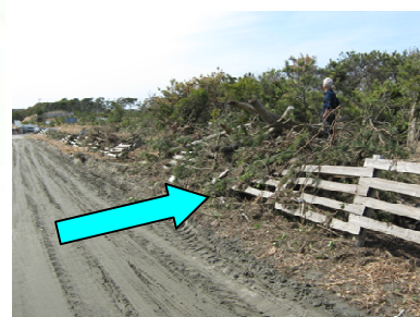
防風柵の倒壊（旭市）
