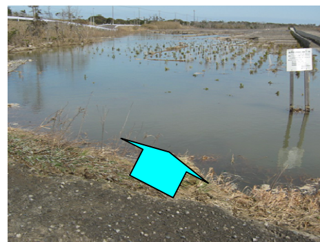
植栽地の冠水（匝瑳市）
