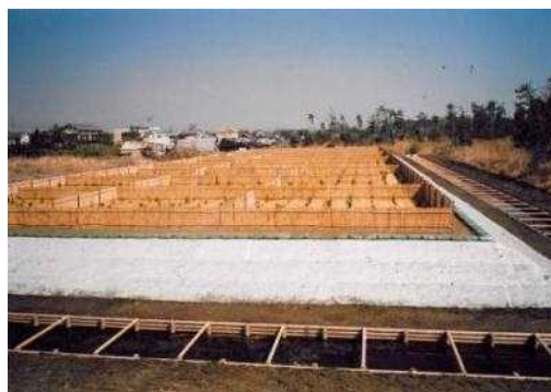
植栽工（盛土造成）と水路工（手前と右横）（九十九里町作田）
