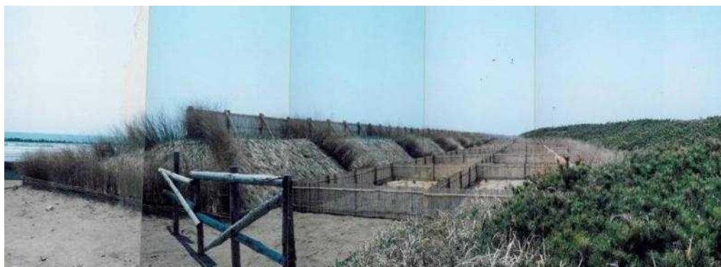
砂丘工～木製防風工～植栽（旭市三川）
