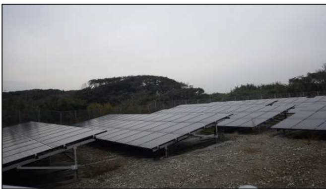
<事例1>太陽光パネルを設置
