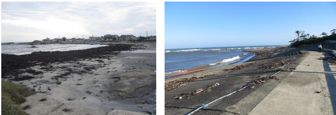
図6-14 重点区域の様子(南房総市) (平成30年10月)
