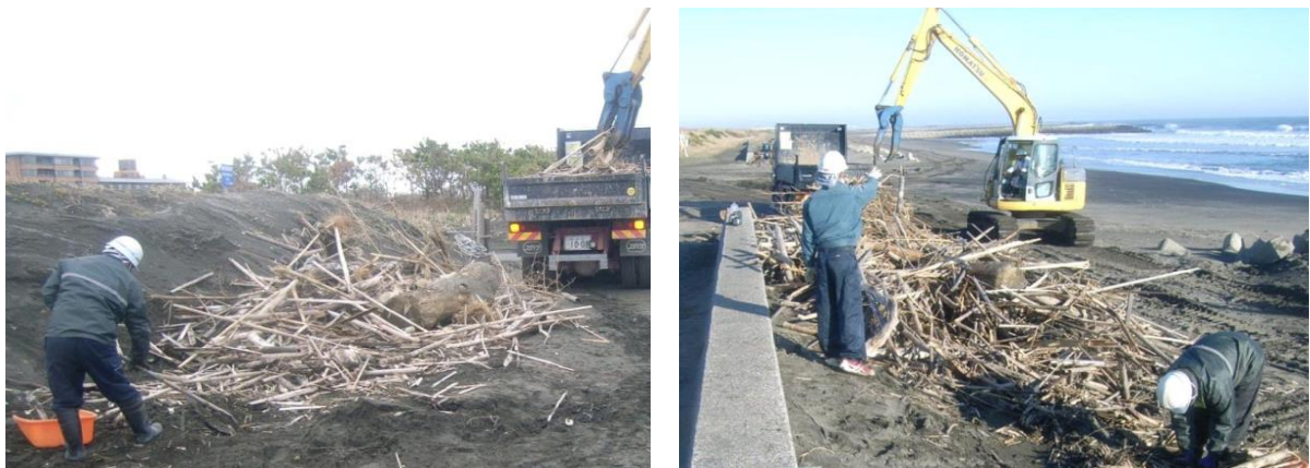
図6-28 重点区域の様子（一宮町） （令和元年11月）
