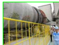
堆肥を投入したキルン
