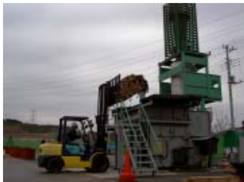
製材残材投入風景(東金市山田)
