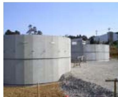
メタン発酵槽基礎工事・続(山田町)
