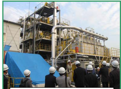
下水汚泥ガス化発電システムの視察
