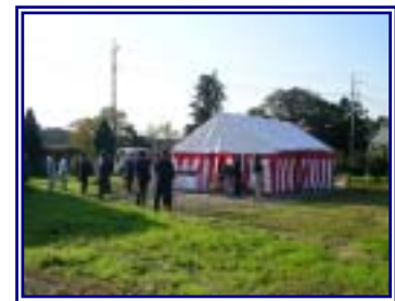
プラント群建設予定地
