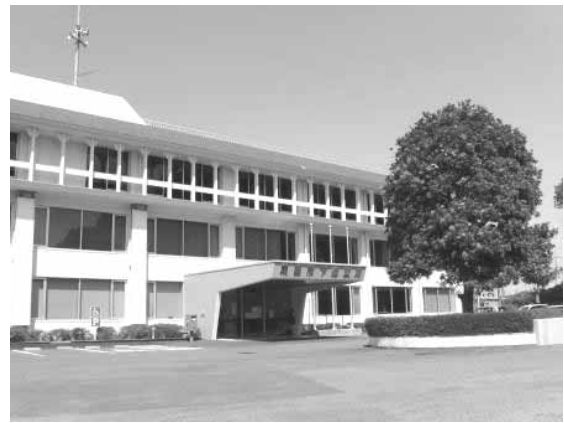
旧下総町役場（現下総支所）
