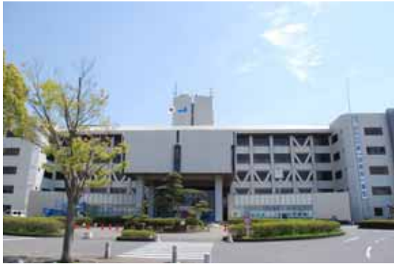
印西市役所本庁舎
