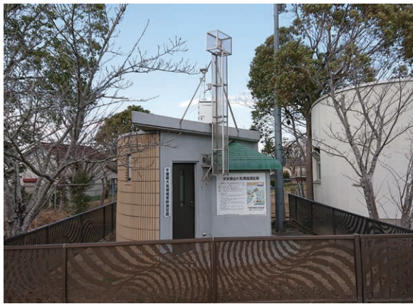
大気環境常時監視測定局(栄町安食台)
