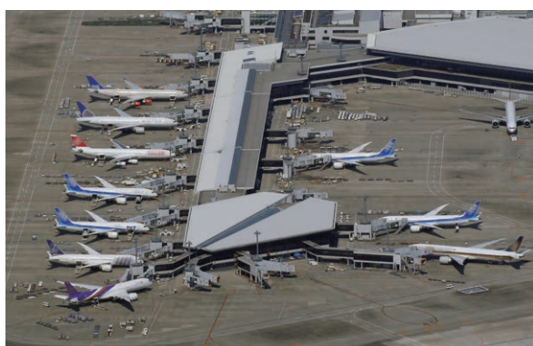
成田国際空港(第1ターミナル)(提供:成田国際空港株式会社)
