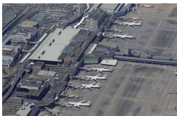
成田国際空港(第2ターミナル)(提供:成田国際空港株式会社)
