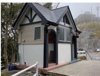
観光公衆トイレ(鴨川市「清澄植物公園トイレ」)
