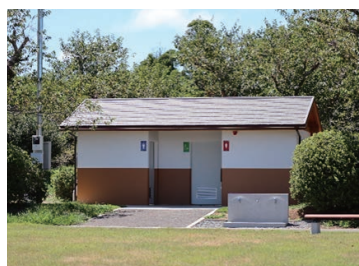
雲井岬つつじ公園トイレ(東庄町)
