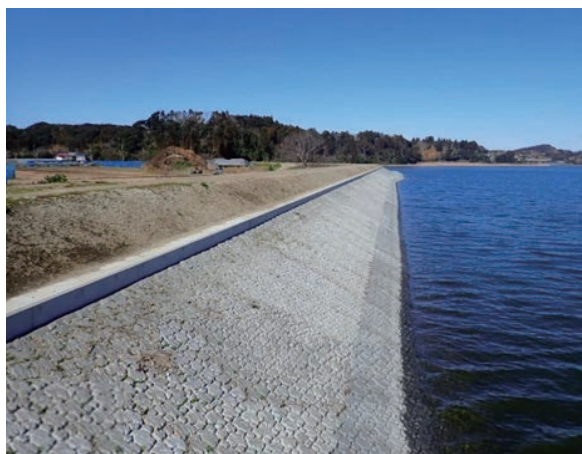
防災重点農業用ため池の改修(左:改修前、右:改修後)
