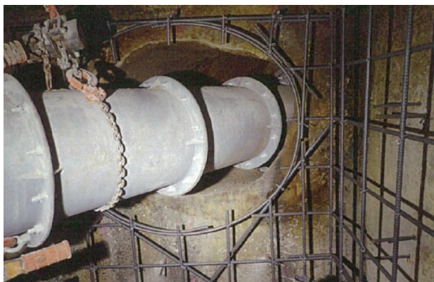
流域下水道マンホールの耐震補強
