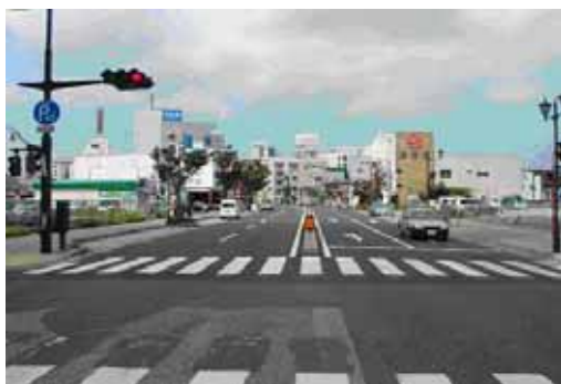
無電柱化の推進 ( 県道木更津停車場線 )
