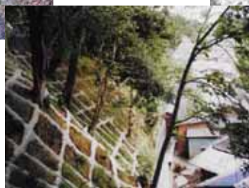
急傾斜地崩壊 対策事業
