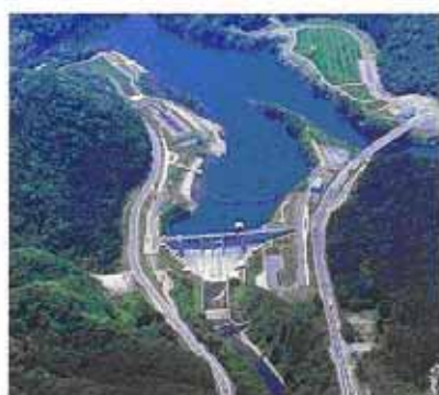
河川総合開発事業（片倉ダム）
