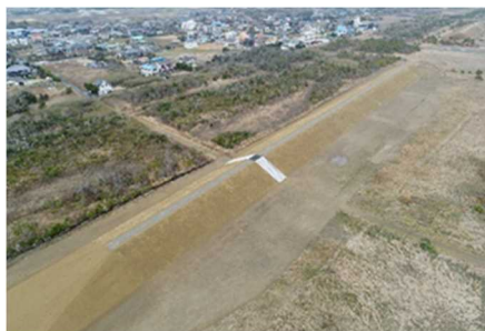
津波堤防 本須賀海岸(山武市)
