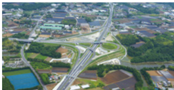
人とモノの流れをスムーズにする「圏央道（大栄ジャンクション）」（提供：東日本高速道路株式会社）
