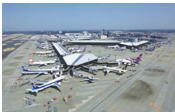
年間約 3,700 万人が利用する日本の表玄関「成田国際空港」 (提供：成田国際空港株式会社)
